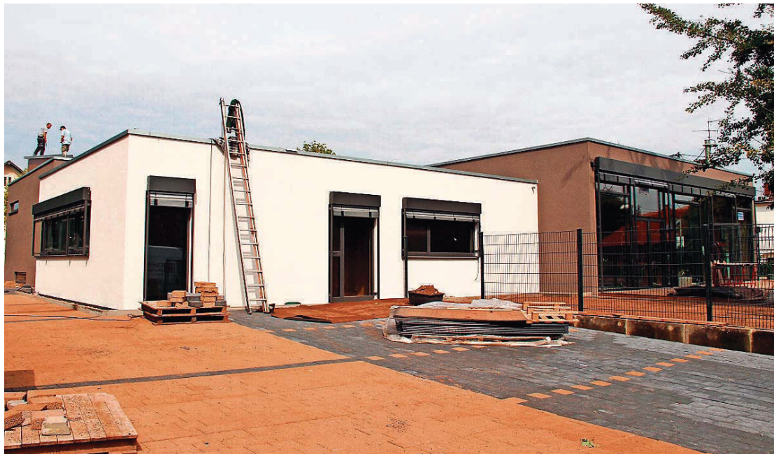
Die letzten Arbeiten an der Kinderkrippe in Wallerfangen laufen.
