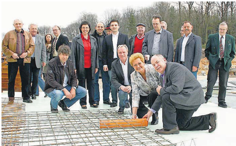
Die Zeitkapsel platzierten die Landrätin Monika Bachmann und der Saarwelliger Bürgermeister Michael Philippi im Fundament, in das sie einbetoniert wird.
